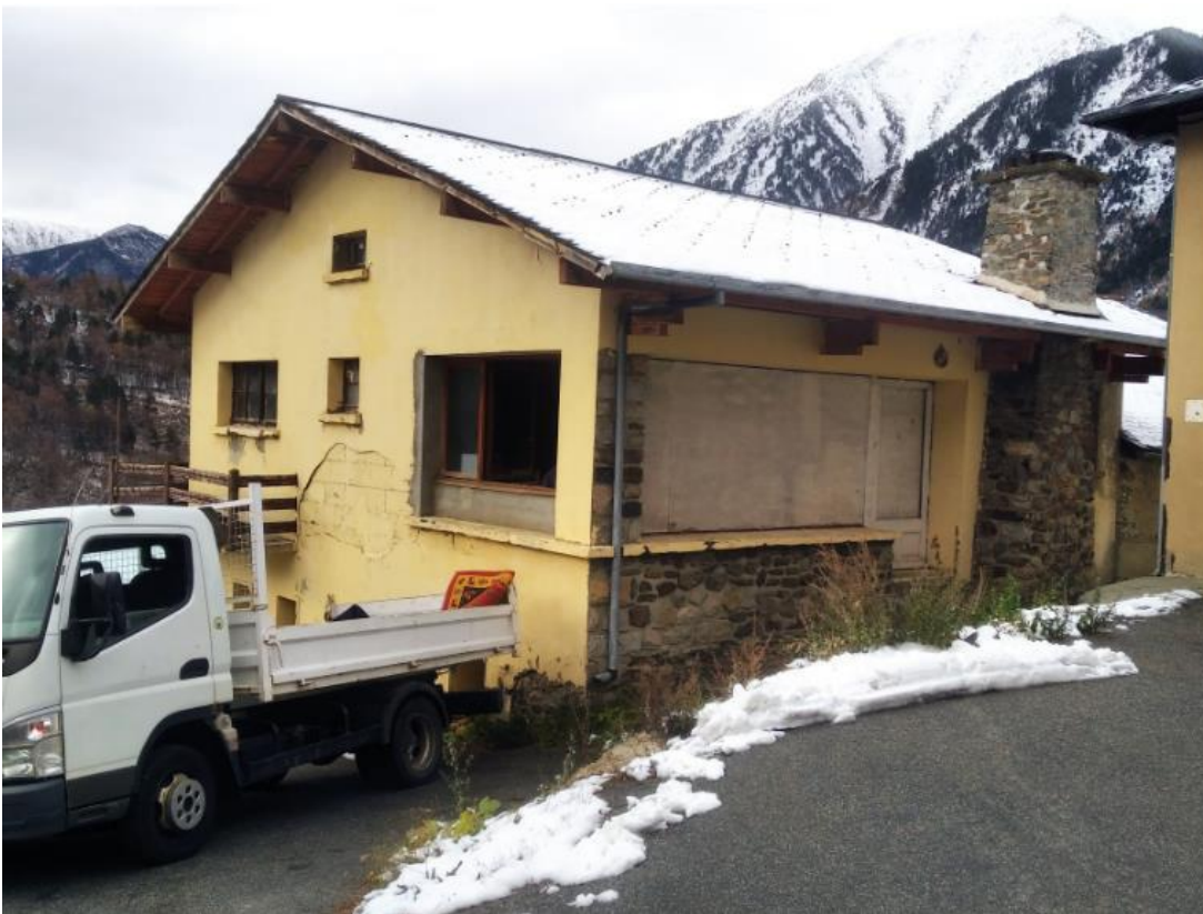
Extérieur face nord : entrée appartement du haut
