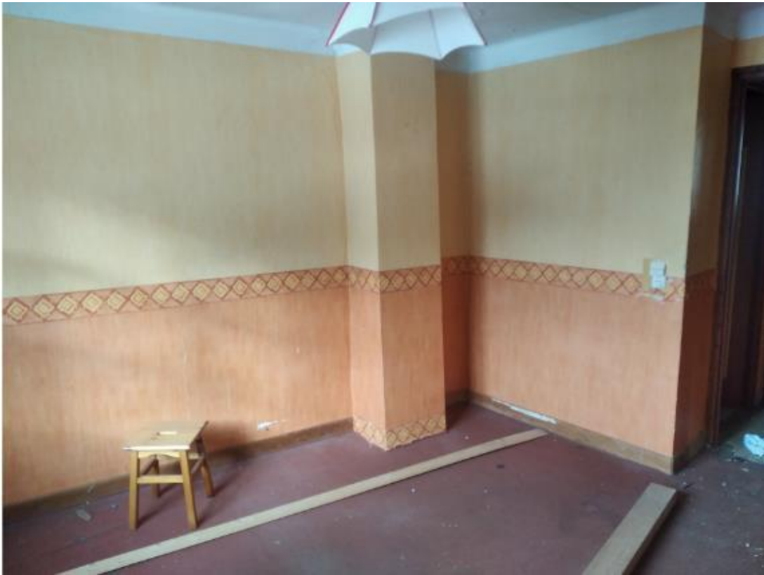
Appartement du haut : chambres
